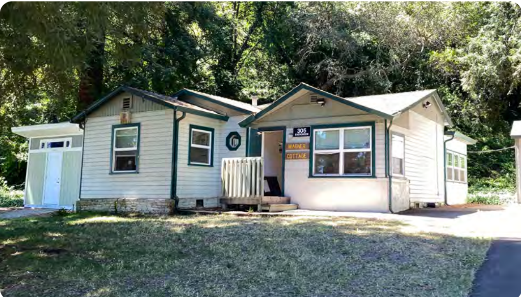
Wagner Cottage Casa de Campo Wagner
