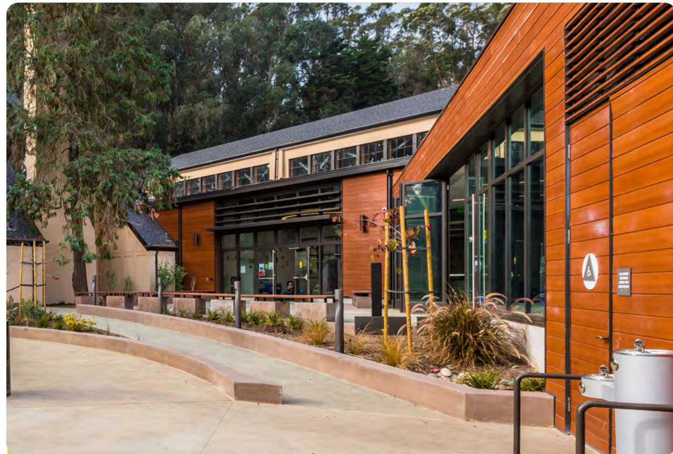
New Multi-Use Facility Nueva Instalación de Usos Múltiples
