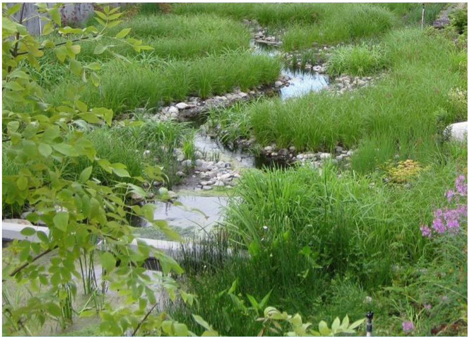
Sinuous low flow stormwater channel Canal sinuoso de aguas pluviales de bajo caudal
