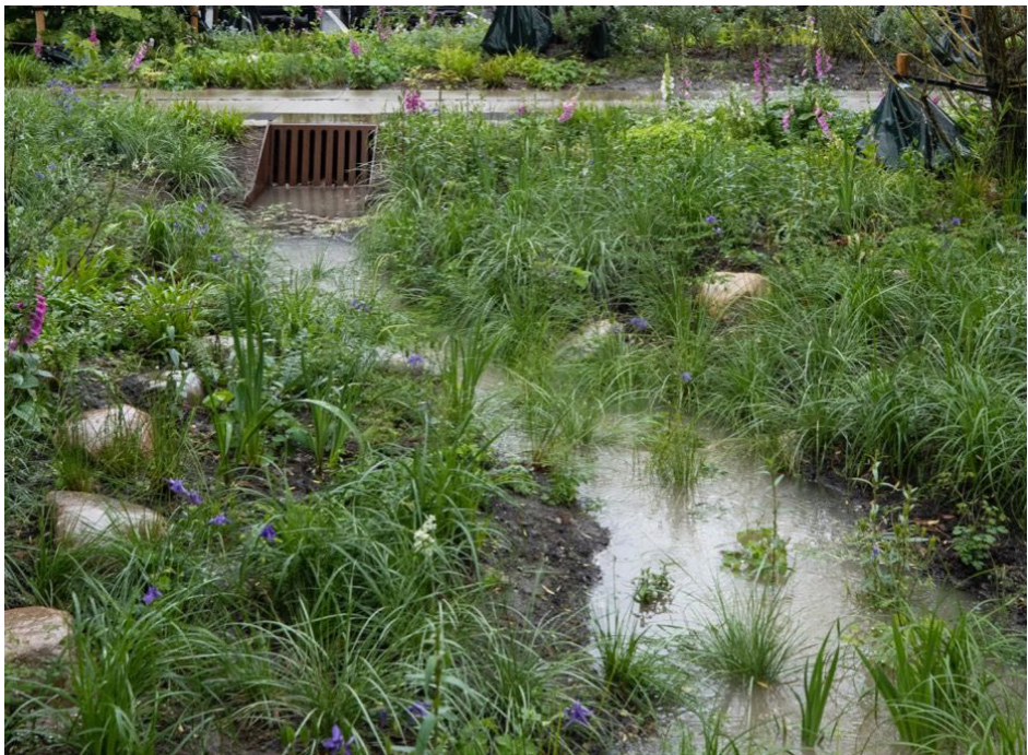
Low flow stormwater channel Canal de aguas pluviales de bajo caudal
