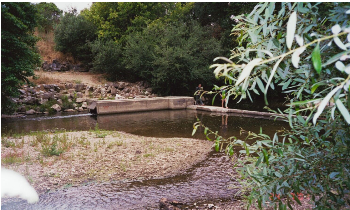
TAIT DIVERSION DAM
