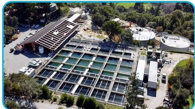
La Planta de Tratamiento de Agua de Graham Hill es una planta de tratamiento de agua convencional que utiliza coagulación, floculación, sedimentación, desinfección y filtración para tratar las fuentes del SLR y los pozos Tait, Loch Lomond y la Costa Norte.
