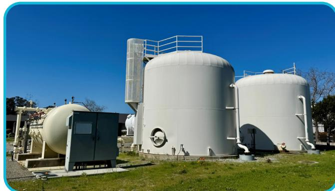
La Planta de Tratamiento de Agua de Beltz es una planta de tratamiento de aguas subterráneas que utiliza el proceso de la oxidación del hierro y el manganeso, la aireación y la filtración directa para tratar el agua que viene de los pozos 8, 9 y 10 de Beltz.
